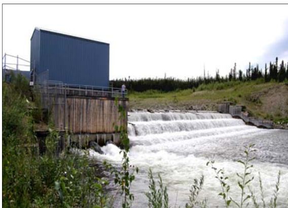
Mayo control structure
