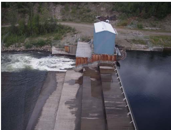
Mayo control structure
